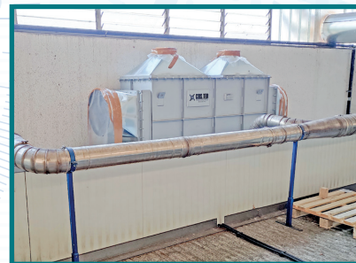
Recuperatore di calore in fase di installazione.
